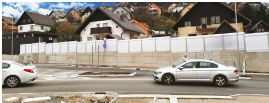
PHO & zaščitna ograja stanovanjskega objekta - lito akrilno steklo opalne barve
