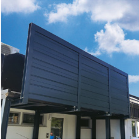
PHO ograja – zaščita pred hrupom (klimati) - ALU absorpcijski paneli
